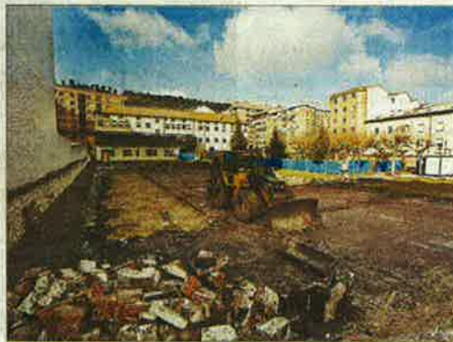
Vista de las obras. Al fondo, el edificio actual. / PATRICIA
